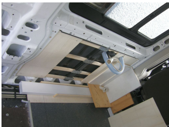
Seitliche Wandisolierung im Bereich Küchenblock, Wasserzulauf und Elektroversorgung sowie Aufbau einer hölzernen Tragestruktur dafür.
